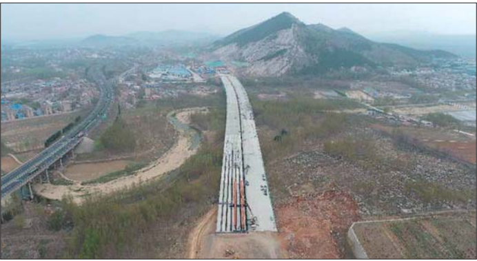
京沪高速改扩建工程南官庄大桥箱梁全部架完。 齐鲁晚报·齐鲁壹点记者 刘飞跃 摄
