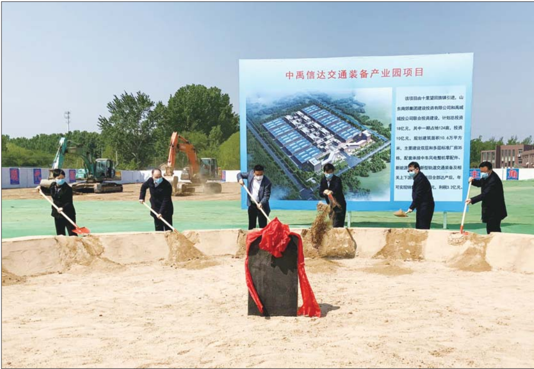
市领导为项目开工培土奠基。
