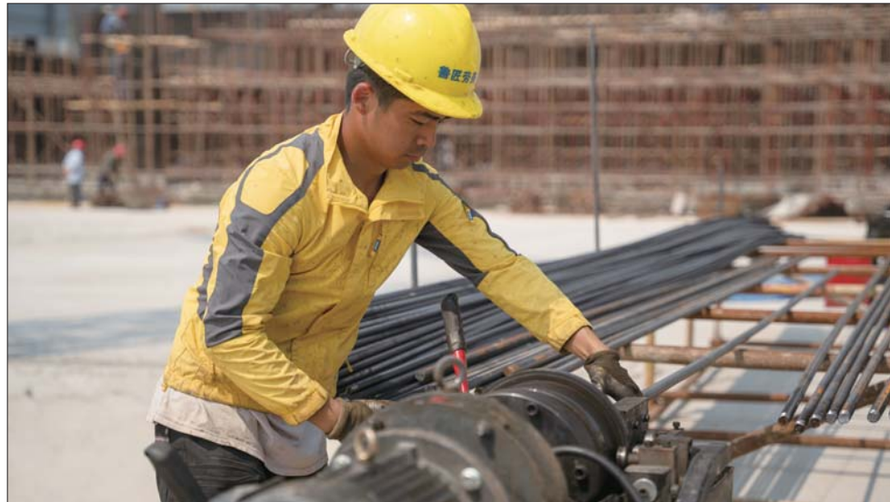
工人正在加工钢筋。
