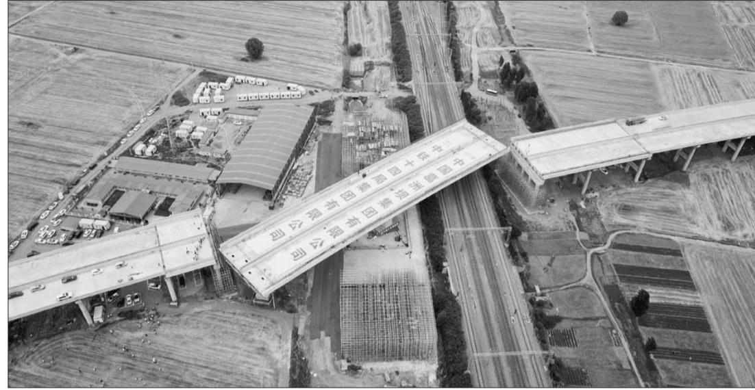
连接线转体桥开始转体,王云一直站在现场指挥部的机器旁,并不时地拿起对讲机确认转体角度。他说:“原设计是逆时针转体,转体角度为107.1度,转体角度大,用时长,后来调整设计为顺时针转体71.2度,保证转体时间控制在70分钟以内。”
