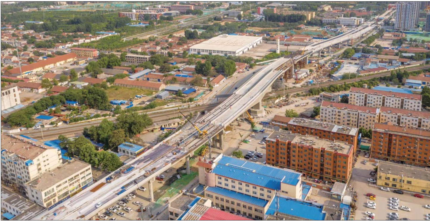
最后一片预制箱梁吊装就位,工程主线成功合龙。
