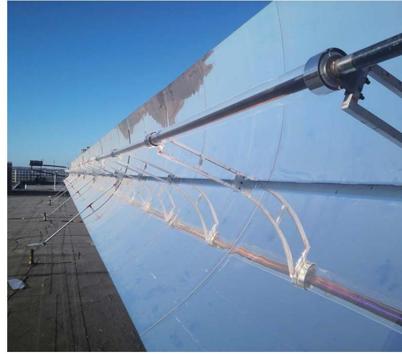
统,为服装熨烫过程提供热量和蒸汽,工作温度达到170℃,在晴好天气可以完全替代生物质锅炉和电锅炉,在为公司创造经济效益的同时,也产生了节能减排的社会效益。
