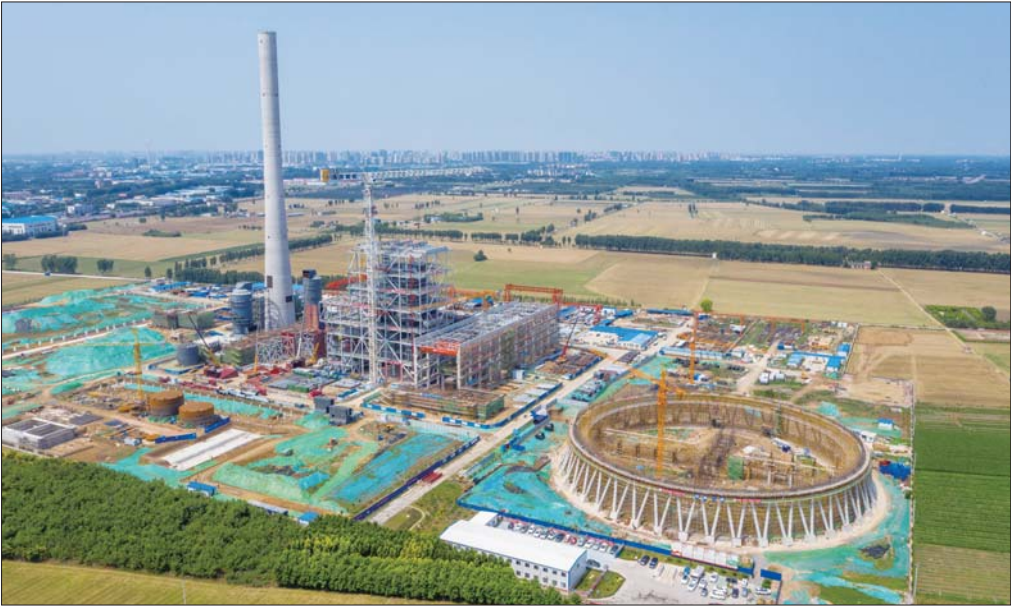
2号机组锅炉钢架开始吊装。
