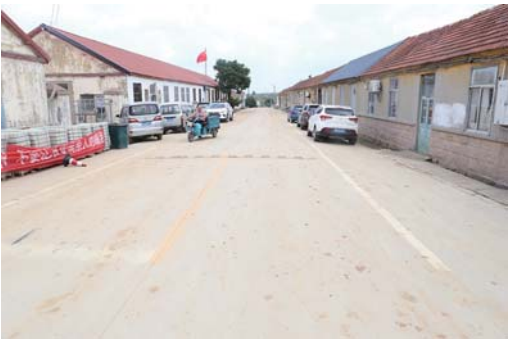
▲五里庄村铺设的主干道。
