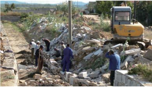
▲东于村浆砌排水沟。
