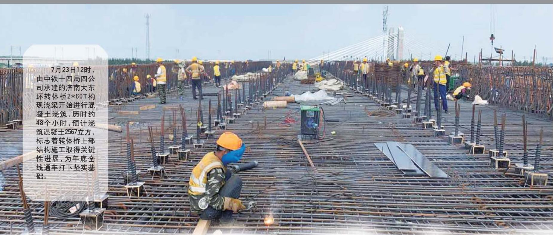
7月23日12时，由中铁十四局四公司承建的济南大东环转体桥2\*60T构现浇梁开始进行混凝土浇筑，历时约48个小时，预计浇筑混凝土2567立方，标志着转体桥上部结构施工取得关键性进展，为年底全线通车打下坚实基础。
