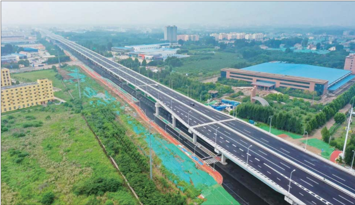
航拍内环高架一标段。
