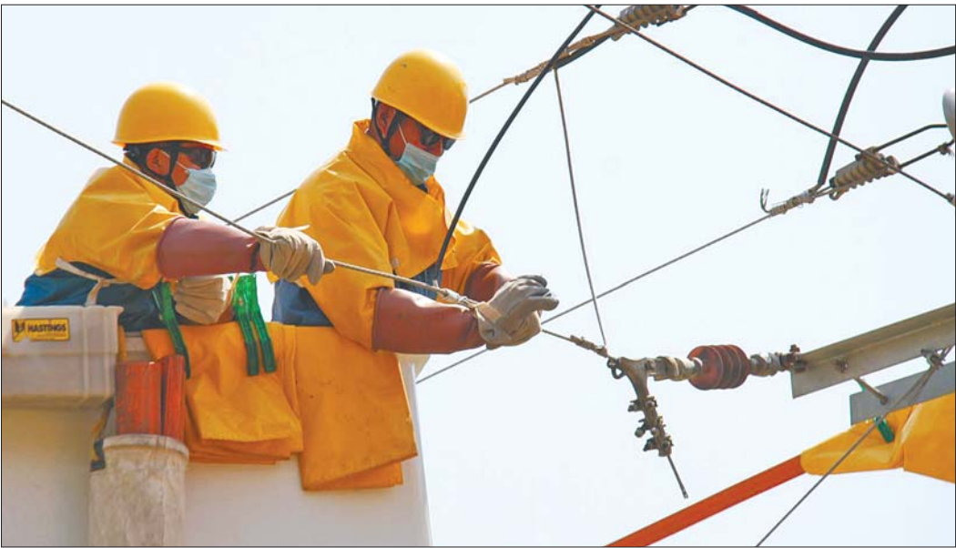
为确保全省电力供应,国网山东电力工作人员加强对重要输电通道、重要设施和重点部位的运维巡视。
