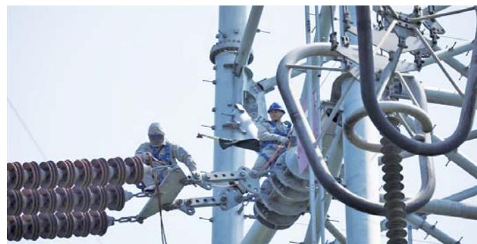
山东电力检修公司决定带电作业。与500千伏、±660千伏带电作业相比,本次特高压带电作业电压等级更高、塔型更复杂、杆塔更高。导线为八分裂导线,而
