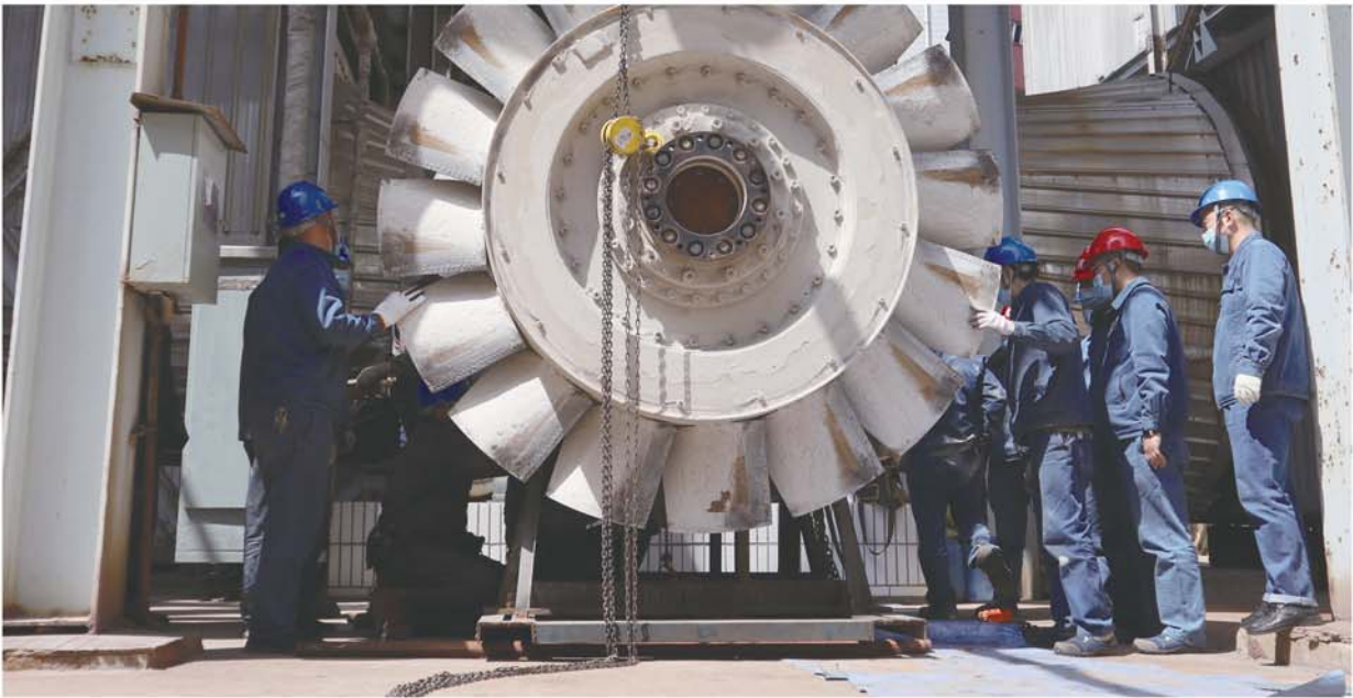
#1炉引风机转子吊装现场。
