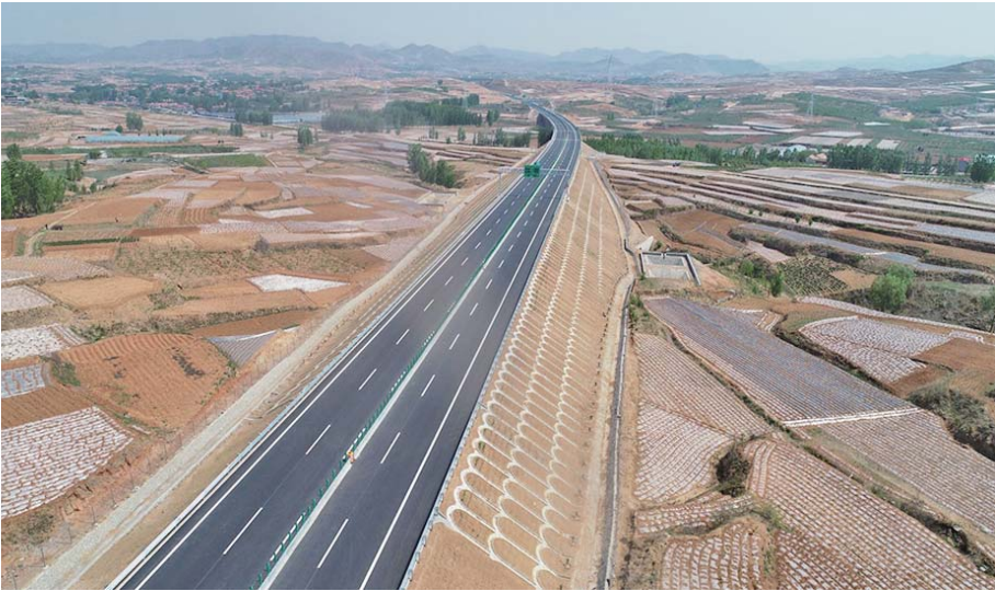
京沪高速新泰段新建分离线施工完成。
