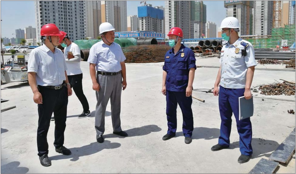
北湖消防大队深入建筑工地开展消防检查。
