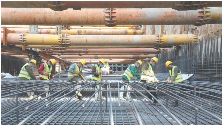
2020年3月，济南地铁2号线历山北路站正在进行车站底板钢筋绑扎作业。
