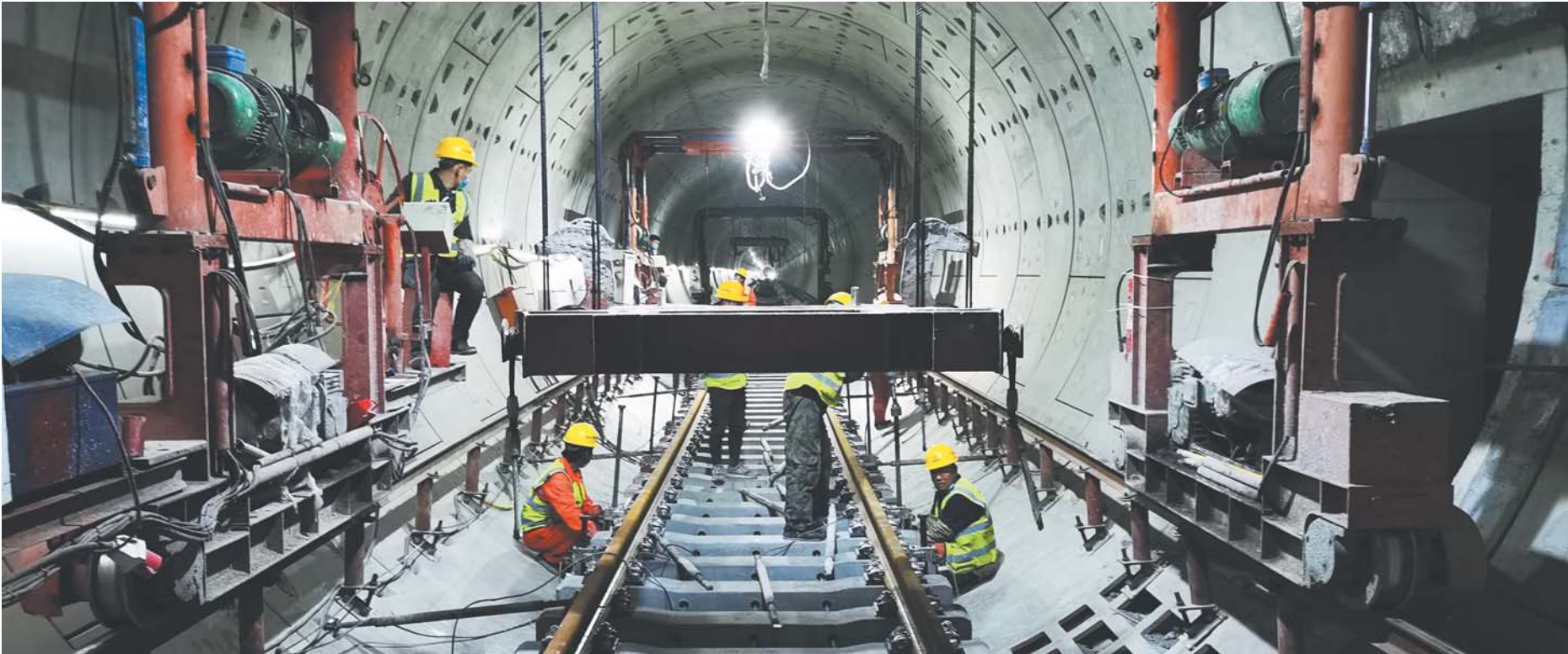
2020年3月，济南地铁2号线开源路站至烈士陵园站区间隧道内，正在进行机械铺轨作业。
