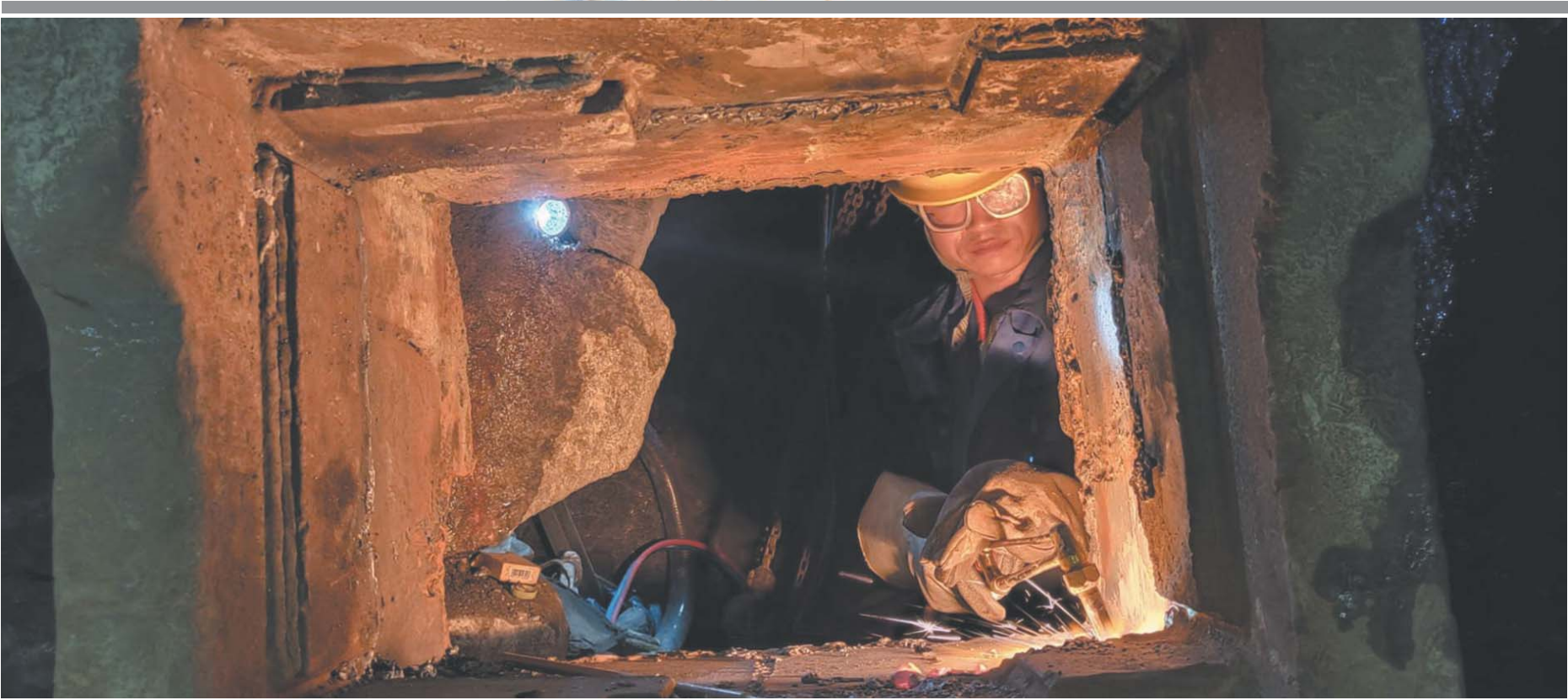
盾构机掌子面狭窄空间，工人对损坏刀箱进行割除。通讯员 赵山杰摄
