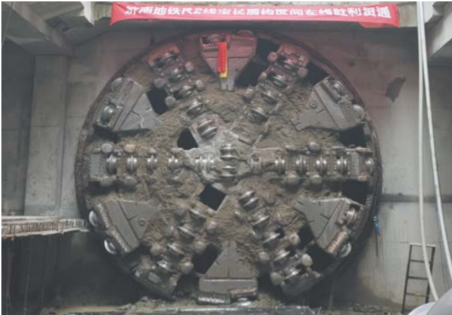
宝华街站—长途汽车站盾构区间左线隧道贯通。通讯员 赵山杰摄
