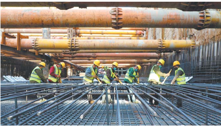
历山北路站施工人员进行钢筋绑扎。
