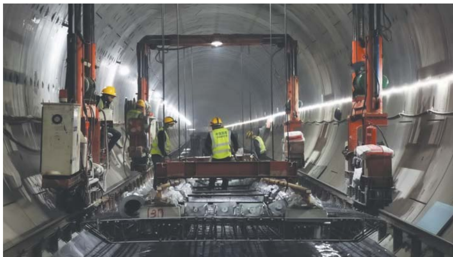
工人用铺轨小吊铺设任家庄到腊山区间减震道床。 通讯员 覃曾阳摄
