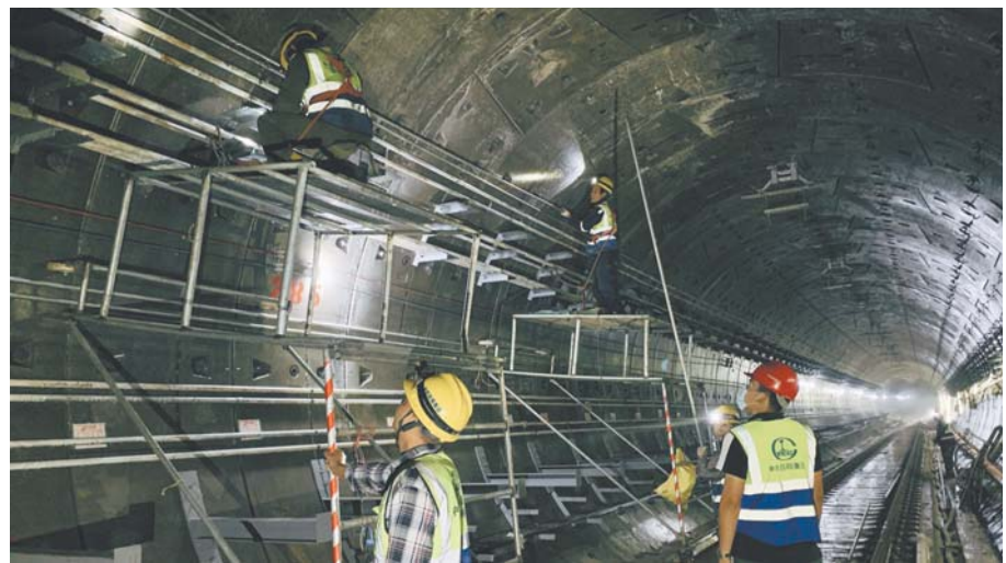
济彭区间线管安装。 通讯员 王建摄
