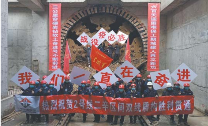
济南轨道交通2号线二环东路站——辛祝路站区间双线贯通。
