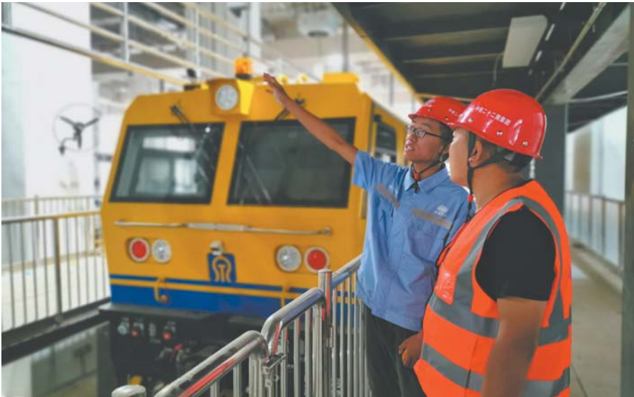
中铁二十二局施工人员正在对钢结构检修平台进行检查验收。
