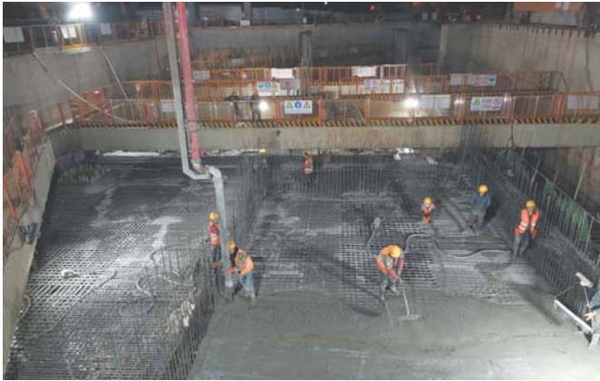
济南地铁2号线辛祝路站混凝土施工。
