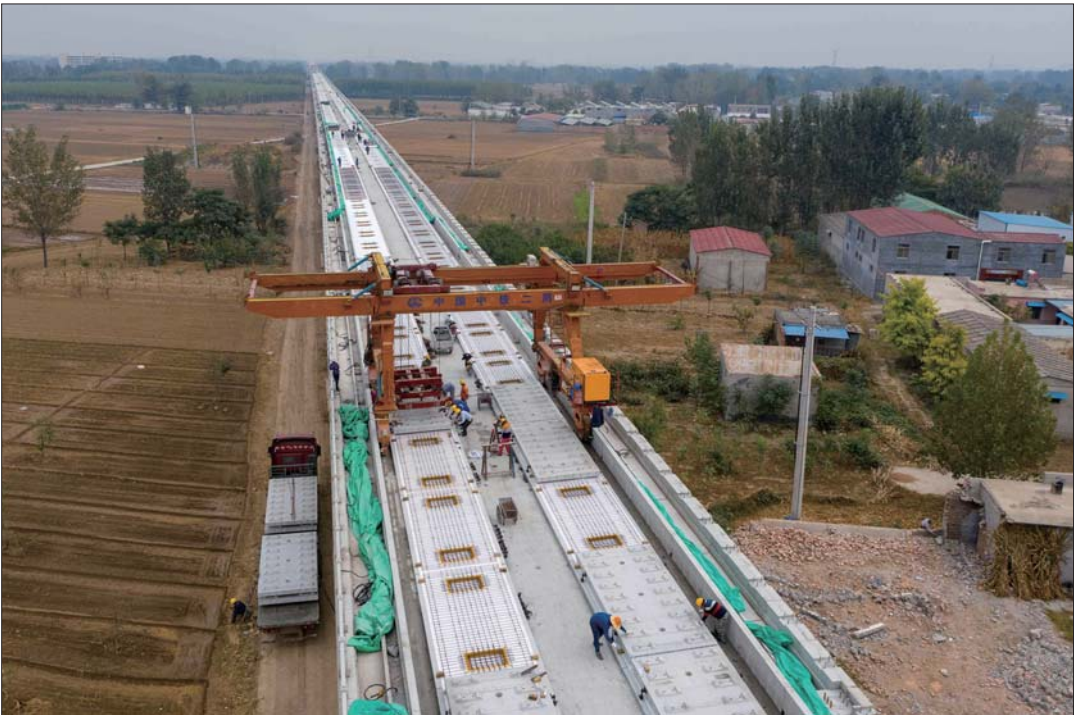
鲁南高铁梁宝寺铁路特大桥完成桥梁主体架设,施工人员正进行桥面无砟轨道铺设。
