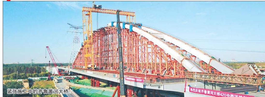
布置(95+280+420+280+95)1170米,主跨跨径420米,次中跨跨径280米,边跨梁长95米。吊杆采用400MPa超高应力幅钢绞线拉索,网状布置。
