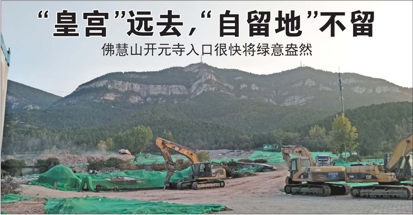
佛慧山开元寺入口改造提升工作所涉及的建筑基本已拆除完毕。 齐鲁晚报·齐鲁壹点记者 李培乐
