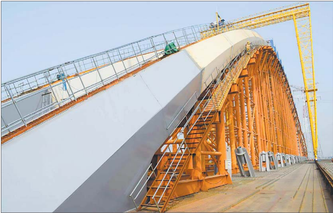
一条优美的弧线横卧在齐鲁黄河大桥280米首跨上,这就是顺利合龙的大桥拱肋。 齐鲁晚报·齐鲁壹点记者 刘飞跃 摄
