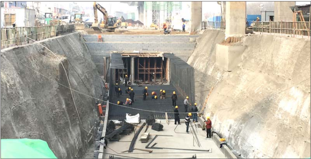
工业北快速路建设时进行了地下分层开发,浅层进行地下综合管廊建设。 本报记者 王皇 摄
