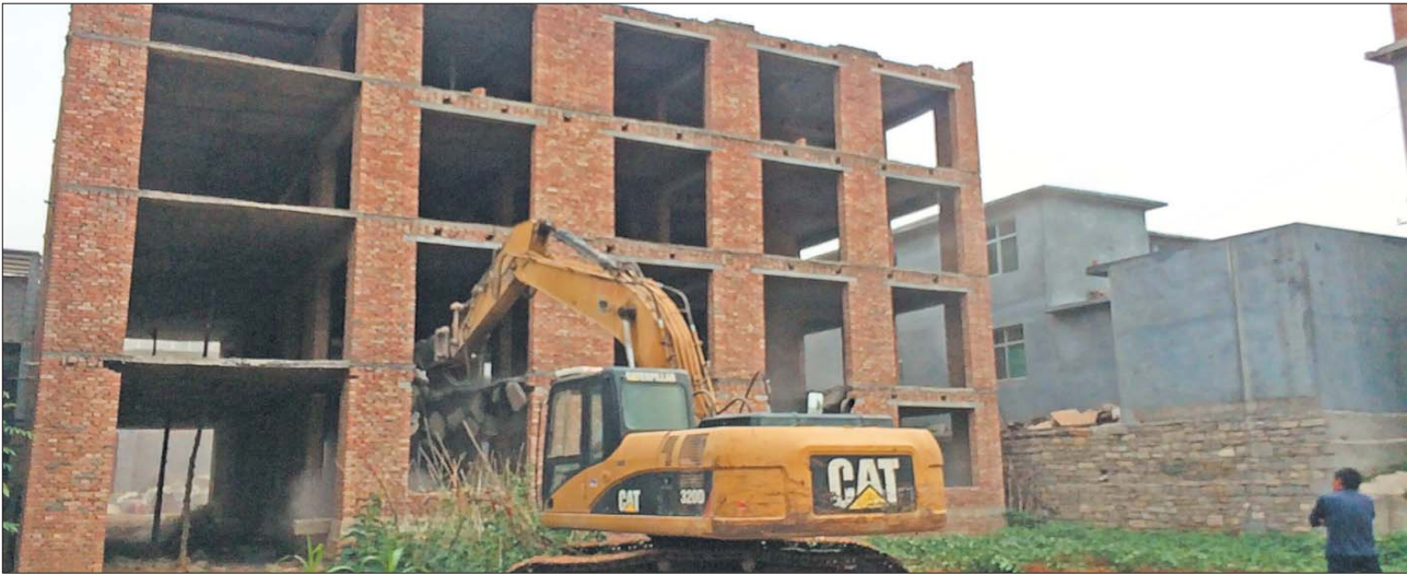
付上村一栋4层高的楼房正被拆除。
