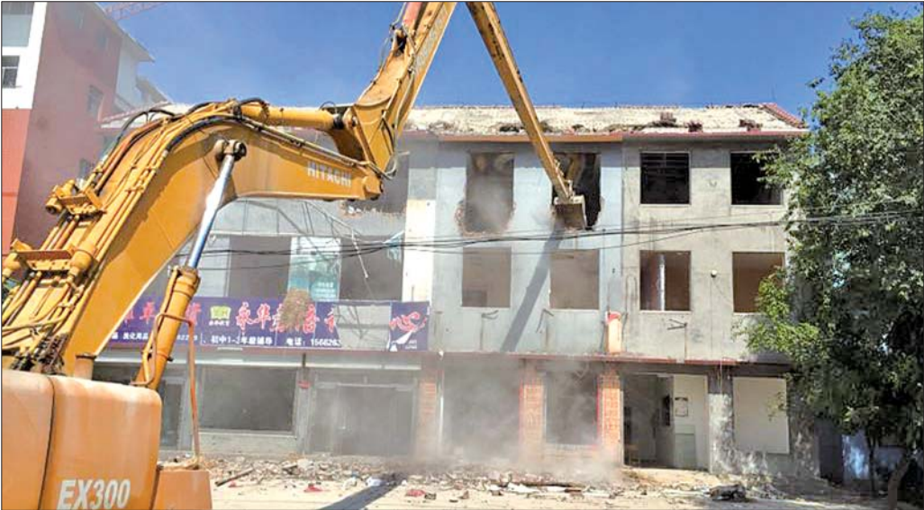
济北小学南侧违建楼房被拆。 本报记者 刘慧 摄
